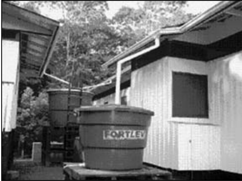
Figura 5 Sistemas de captação e distribuição da água da chuva.
